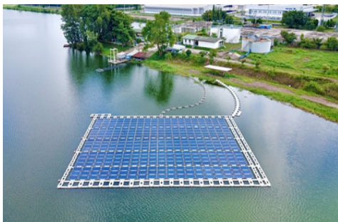
ภาพประกอบ Floating Solar ในอ่างเก็บน้ำตบนิคมอุตสาหกรรมเกตเวย์ ซิตี้ ขนาด 117.35 kWp
