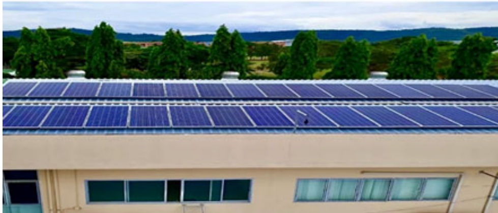
Solar Rooftop บนหลังคาอาคารสำนักงานนิคมอุตสาหกรรมเกตเวย์ ซิตี้ ขนาด 11.70 kWh
