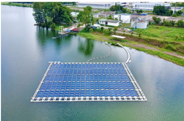
ภาพประกอบ Floating Solar ในอ่างเก็บน้ำดิบนิคมอุตสาหกรรมเกตเวย์ ซิตี้
