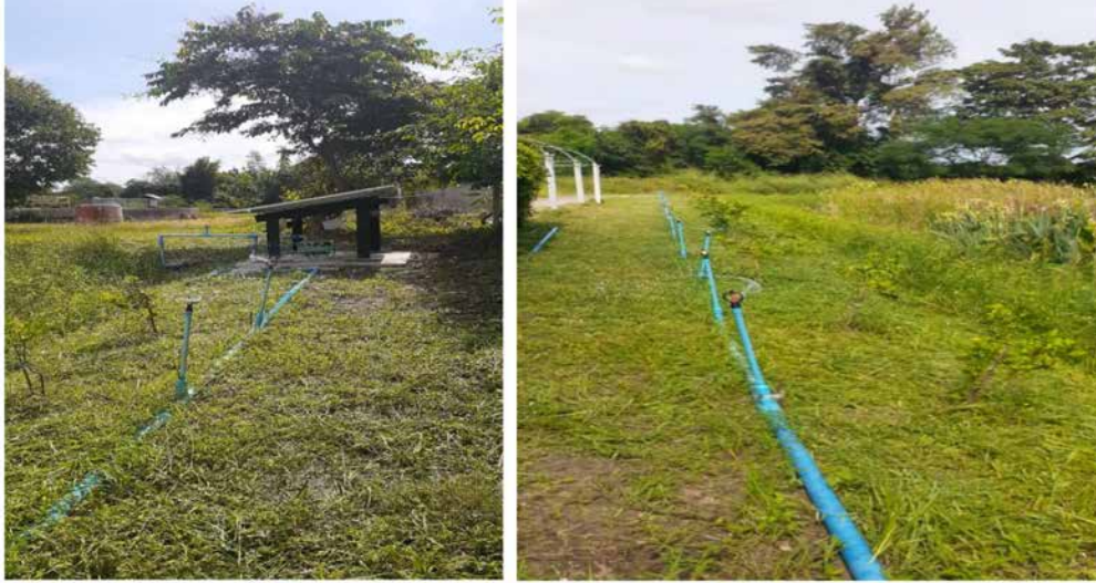
ภาพประกอบมีการผันน้ำที่ผ่านการบำบัดน้ำเสียกลับเข้าใช้รดน้ำต้นไม้
